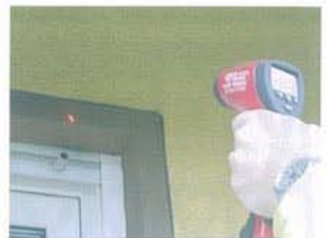
Bild 6: Mit einem Fernthermometer wird die Außentemperatur eines Gebäudeteils gemessen. Der Laserstrahl ist als heller Fleck erkennbar und zeigt die Messstelle.
